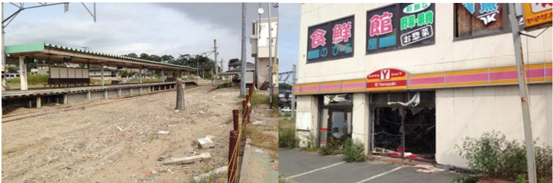
写真 9 津波の被害を受けた電車の駅と周辺施設
